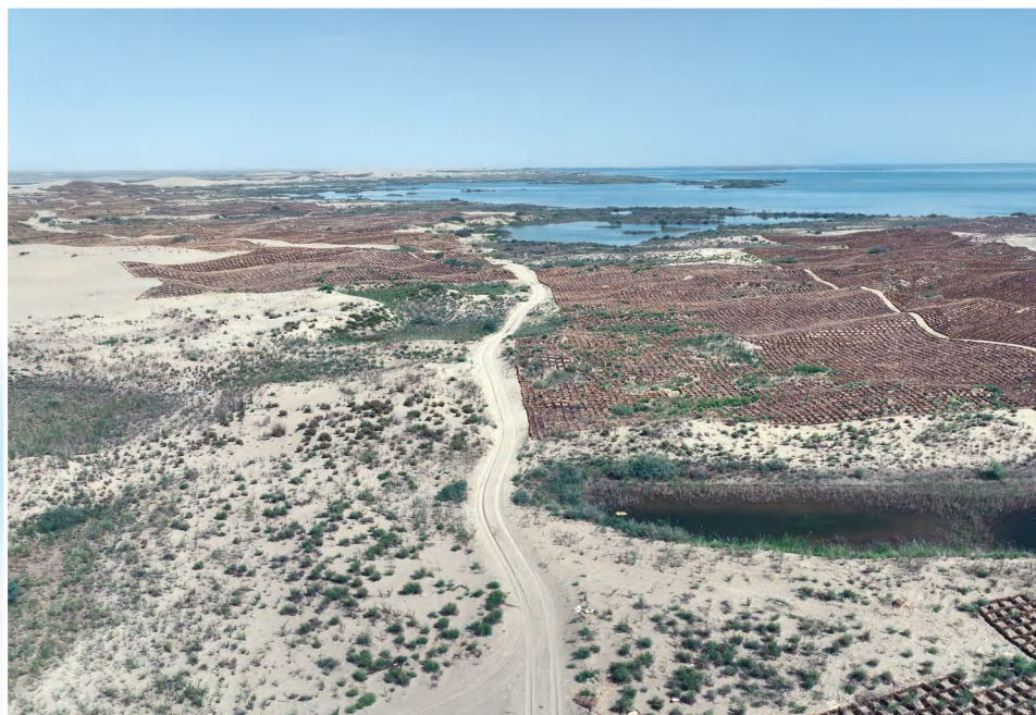
第二师恰拉水库东侧水土保持重点工程小流域综合治理提质增效项目
